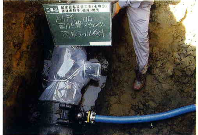
工事場所 匠瑛市野手地先（県道八日市場 - 野栄線） 工事内容 昭和51年度に布設した鋼管を耐震性に優れたフレキシブルステンレス管へ布設替えしました。
