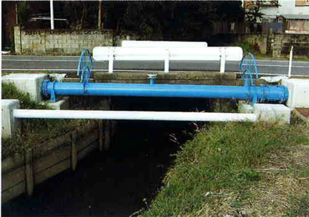
工事場所 横芝光町母子地先（農業用水路） 工事内容 昭和49年度に架設した鋼製の水管橋を防食性に優れたステンレス製の水管橋（青色部）へ架設替えしました。
