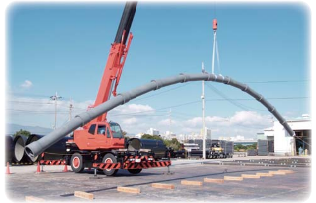
耐震管吊り上げ状況
