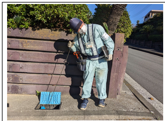
※宅地内調査の様子
